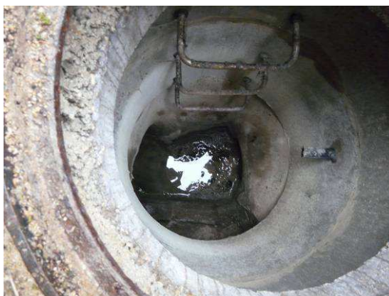
Déversoir d'orage du réseau unitaire à la sortie de Mollon
